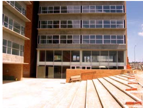
Figura 27 Obra limpa e organizada
