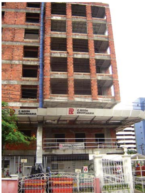
Figura 21 Tubo coletor de entulho despejando no container tipo A
