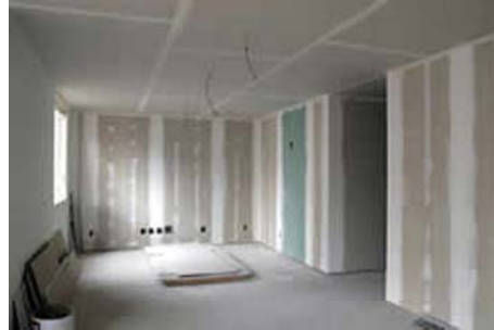
Figura 26 Uso de materiais tipo Dry-wall
